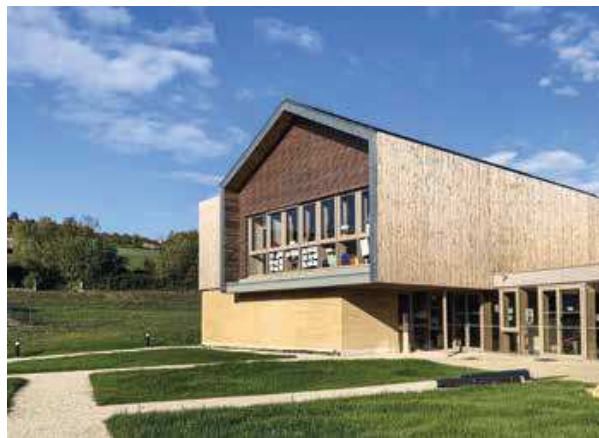
Groupe scolaire de Miribel où les matériaux biosourcés sont utilisés.
